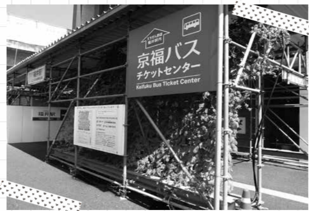
工事中の風景にも緑が映える
