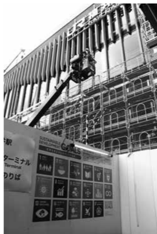
工事中のJR福井駅東口
