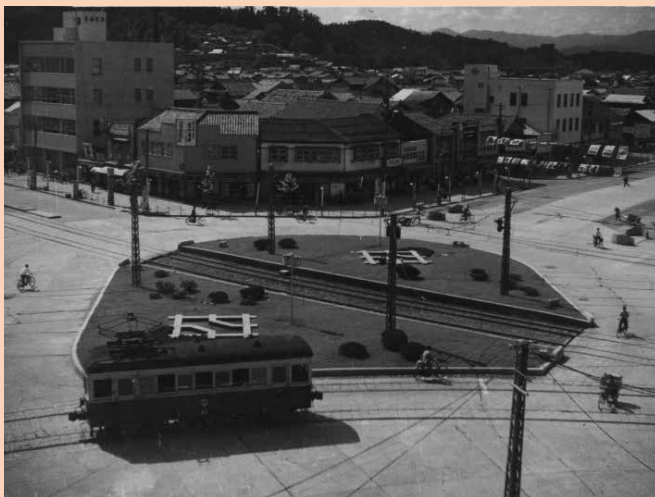
①ロータリーが整備されている昭和29年の様子 (現在の織協ビルの辺りから南西方向を撮影)
