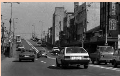
陸橋の完成により、歩車の流れが分離（南東方向に撮影、昭和57年）
