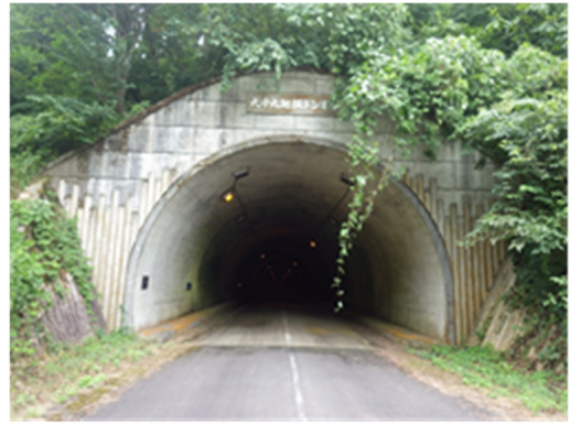
長寿命化対策を講じたトンネル
