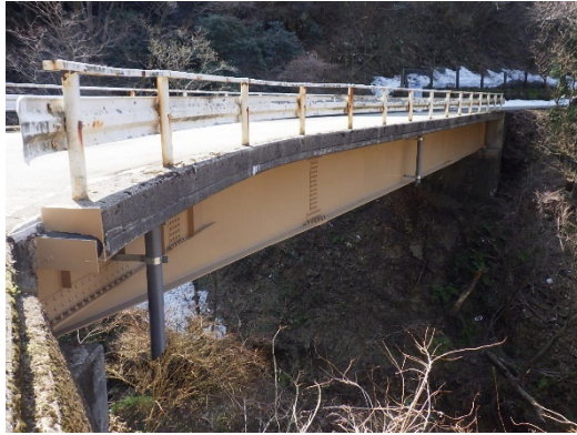
長寿命化対策を講じた橋梁
