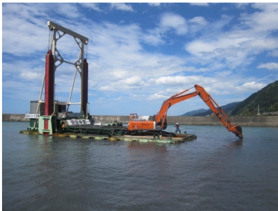
漁港泊地の浚渫
