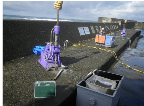
防波堤の改修
