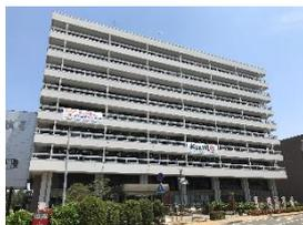
大規模な地震災害時においても業務継続を図り、被災からの復旧・復興を迅速に行うため、耐震性の劣る市庁舎について耐震改修等を行い、市庁舎の耐震性を確保しました。
