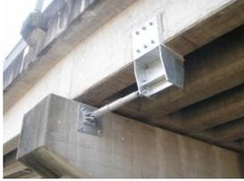
災害直後でも緊急車両の通行を確保するため、新明里橋の耐震補強工事を実施しています。
