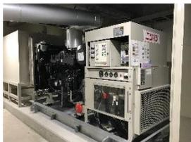
災害時の防災拠点としての機能を向上させるため、本館及び別館に防災機能を確保し、業務継続のため3日間約72時間分の非常用電源が確保できる発電設備を整備しました。（※市役所本館の非常用発電設備は令和4年度中に整備完了予定）
