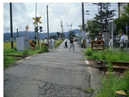
通学路の点検
