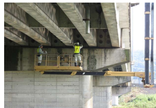
■ 橋梁長寿命化点検
