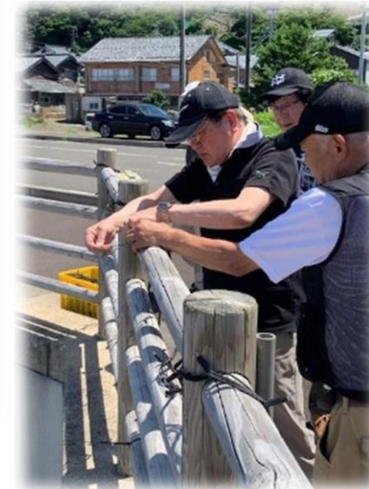
▲越廼海水浴場付近 イルミネーション設置
