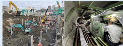
▲ポンプ場建設工事（左）、雨水増補幹線内部
