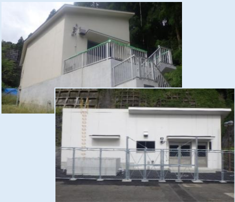
▲西河原浄水場（上）と折立浄水場
