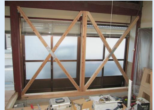
▲耐震改修工事 補強状況
