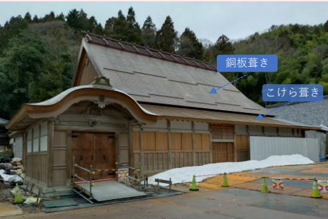
▲修理後の重要文化財 大安寺本堂
