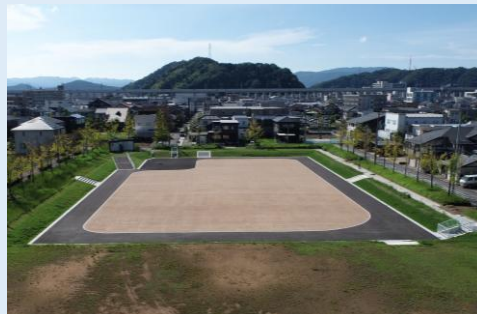
▲鹿江公園調整池
