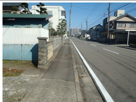
⑥ 地区東側の道路（段差のある歩道）
